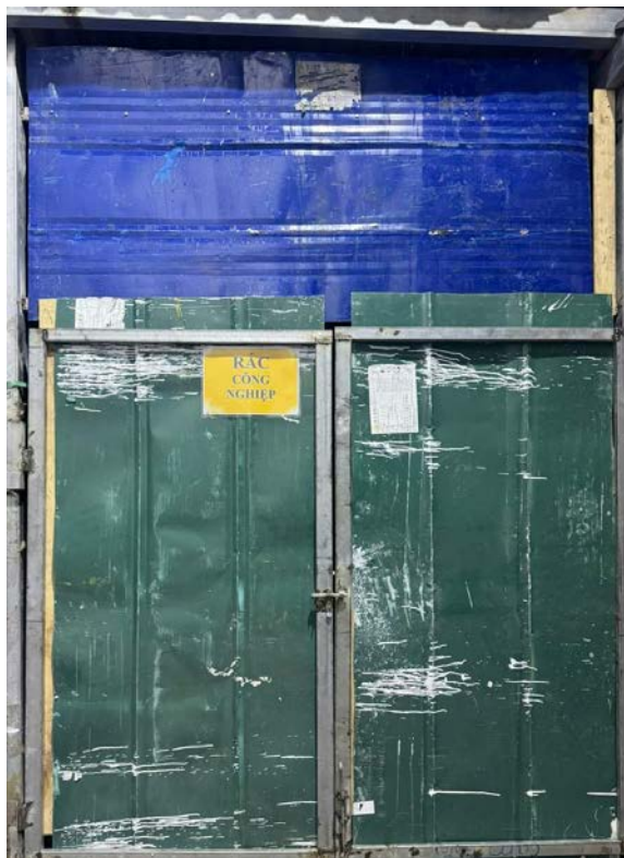
Hình 3.8. Kho chứa chất thải công nghiệp thông thường
